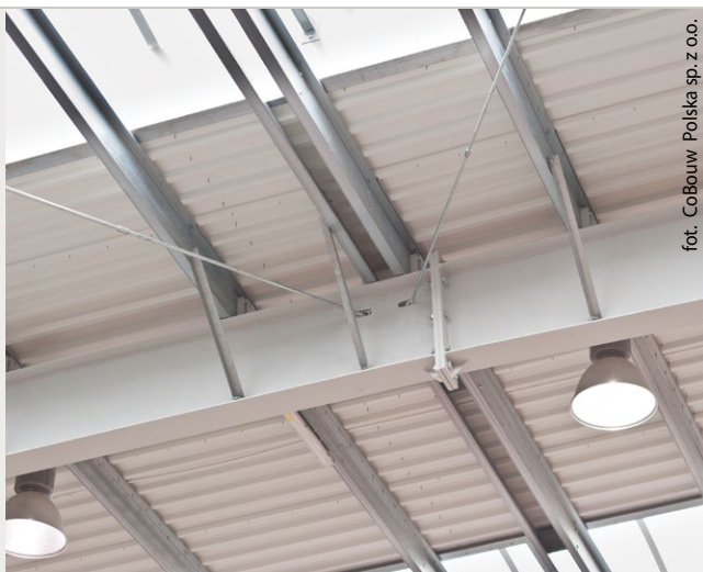
Fot. 2. Dach o konstrukcji ramy pełnościennej z płatwiami z profili zimogiętych typu Z
