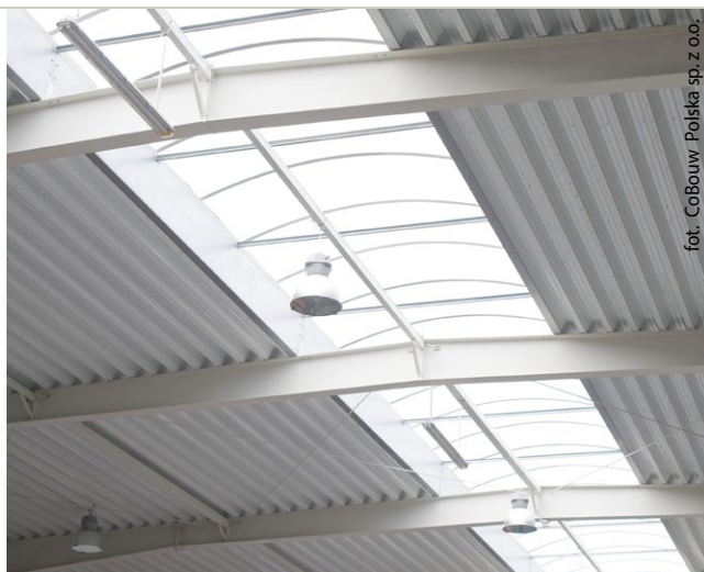
Fot. 3. Hala o konstrukcji ramy pełnościennej, dach bezpłatwiowy
