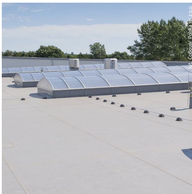
Fot. 4. Światliki kalenicowy na dachu z poszyciem z membrany EPDM
